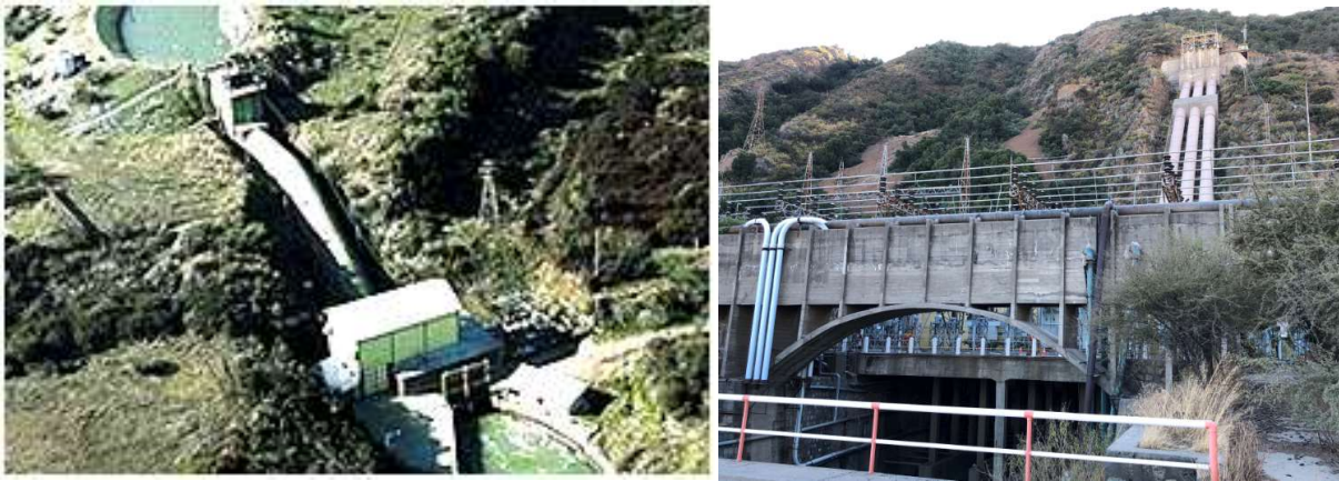
Figura N° 32. Central Sauzalito y Central Sauzal.
