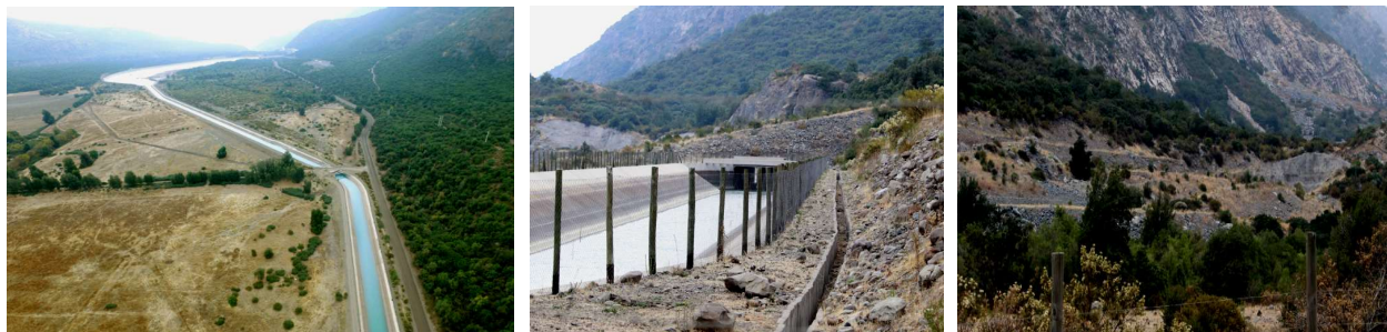
Figura N°36. Canal de desvío de aguas del río Cachapoal (en Chacayes) y río Cipreses, entrada de agua a túnel y salida de agua donde se evidencia la alteración de las unidades vegetacionales.
