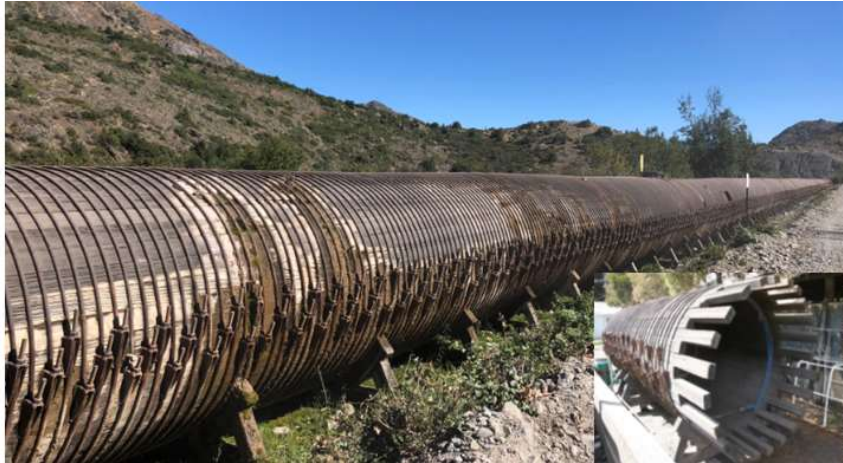
Figura N°35. Tubería de madera de Sequoia que data del año 1917
