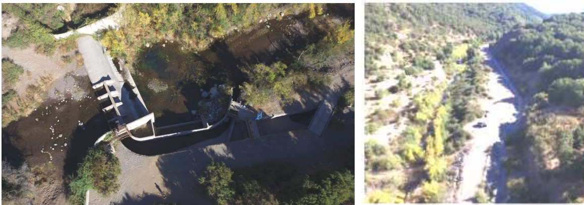
Figura N°39. Bocatoma del estero Los Leones y canal de desvío hacia faenas mineras en sector de Laguna Cauquenes y posterior devolución al río Cachapoal.
