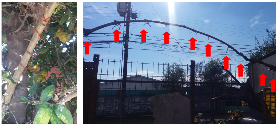
Figura 1. Instalación de emisores en grupo de 10.
