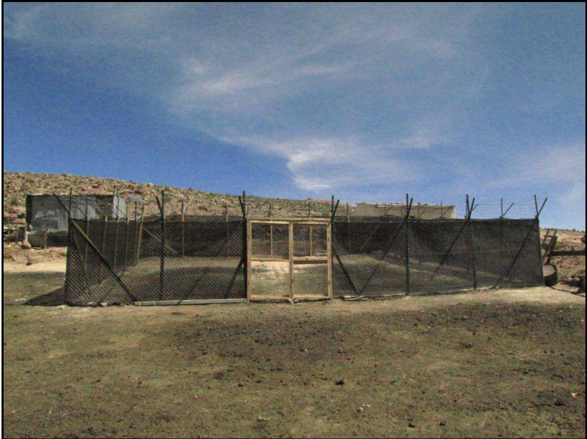
Figura 33. Corral construido en el sector de Chucuyo
