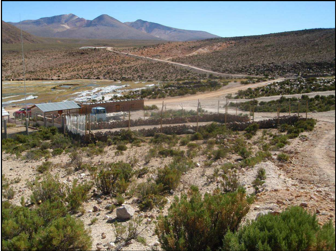
Figura 39. Corral construido en el sector de Parcohaylla.
