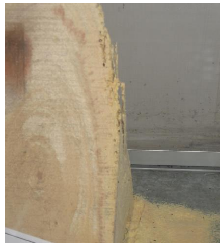
Taco de madera con daño de Sinoxylon anale (Fotografía: SAG)
