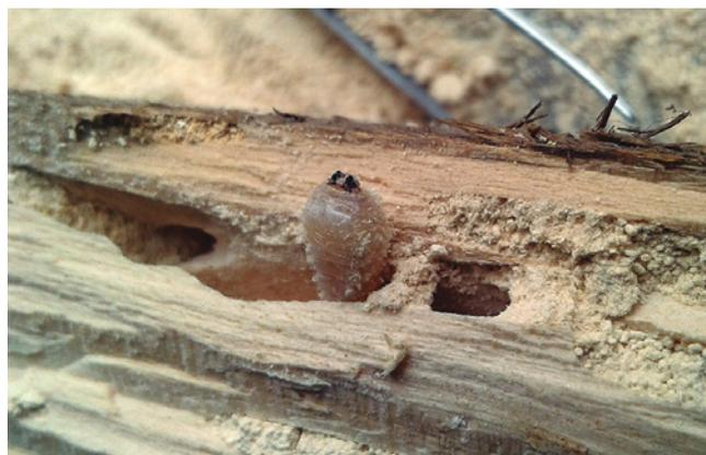
Figura 11. Larva de *Hylotrupes bajulus* en viga estructural.
