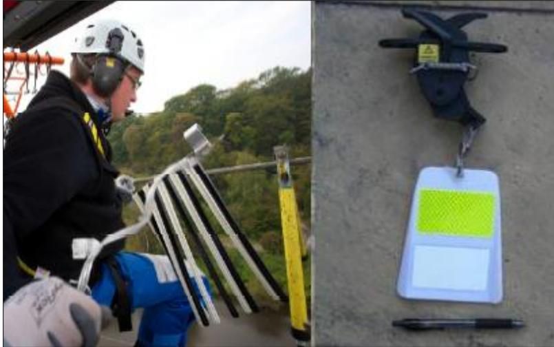
**Figura 4: Izquierda: Dispositivo tipo aleta blanca con negro. Derecha: Dispositivo tipo luciérnaga o libélula (24)**
