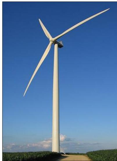
**Figura 8. Torre de tipo tubular DIA Parque Eólico Alena (64)**
