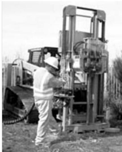
**Figura N°17. Sondeo Mecánico: Equipo de Perforación de Rotación.**
