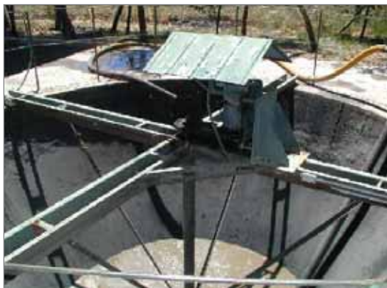
Figura 7. Ecualizador con mecanismo de agitación.
