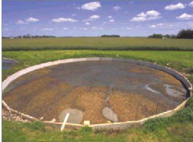
Figura 43. Cubierta de caña de maíz picado sobre estanque de purines
