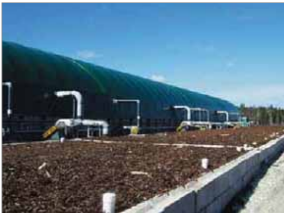
Figura 39. Método de compostaje con contenedores (in-vessel)
