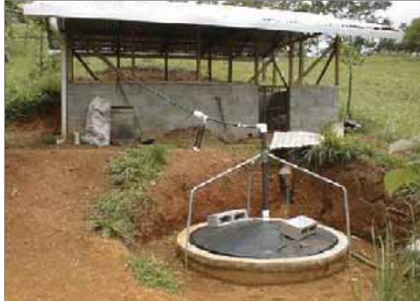
Figura 13. Fotografía de instalaciones de un tratamiento anaeróbico con biomasa suspendida a mezcla completa.
