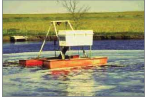
Figura 18. Laguna aireada mediante ventiladores mecánicos.
