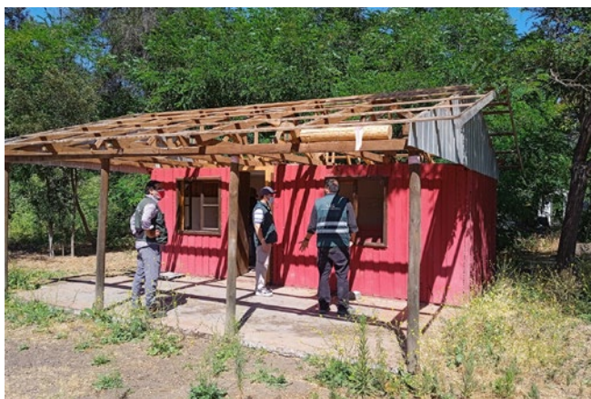
Figura 8. Estructura infestada por Hylotrupes bajulus Linnaeus en sector Peor es Nada de la comuna de Chimbarongo, Región de O'Higgins (Foto Alex Opazo).
